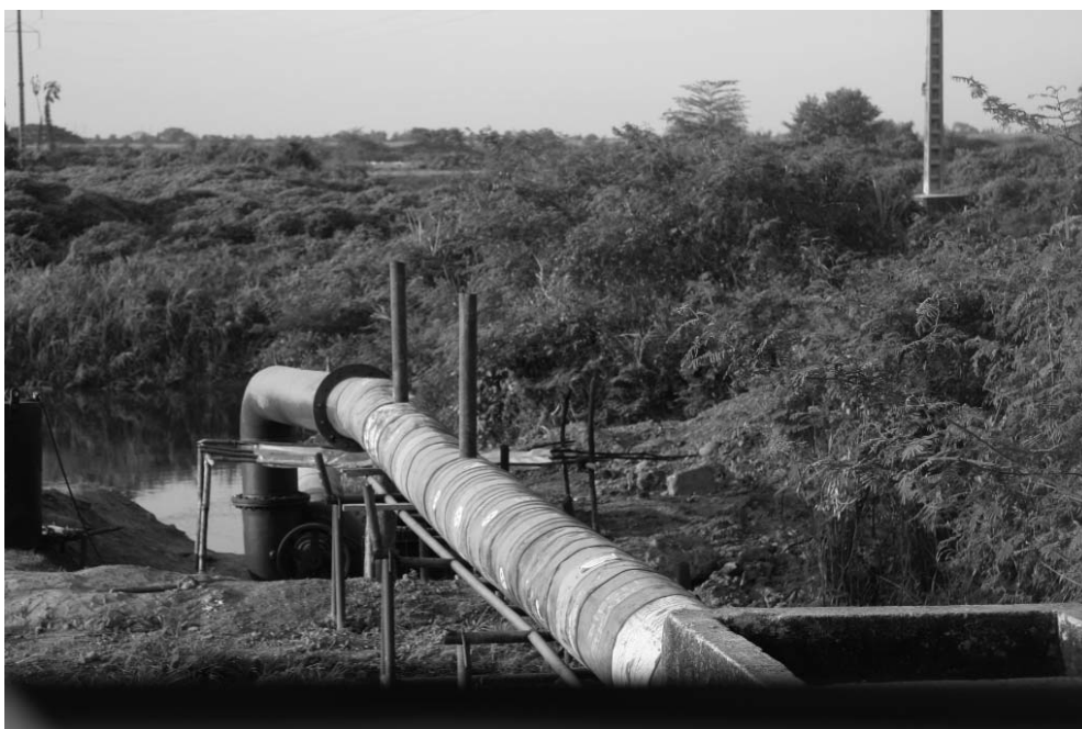
Bombeo de agua subterránea en zona de ingenios
