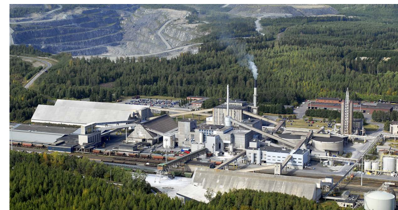
Usine d'engrais et exploitation de roches phosphatées Yara en Finlande.
