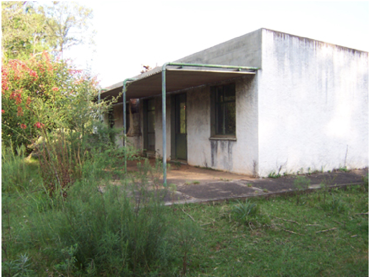
Escuela abandonada cerca de Tanqueras, Rivera
