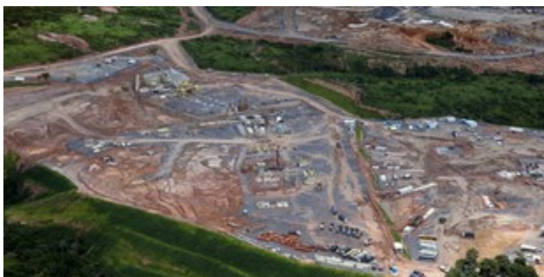
Canteiro de obras da Norte Energia na região de Altamira no Pará, Brasil
