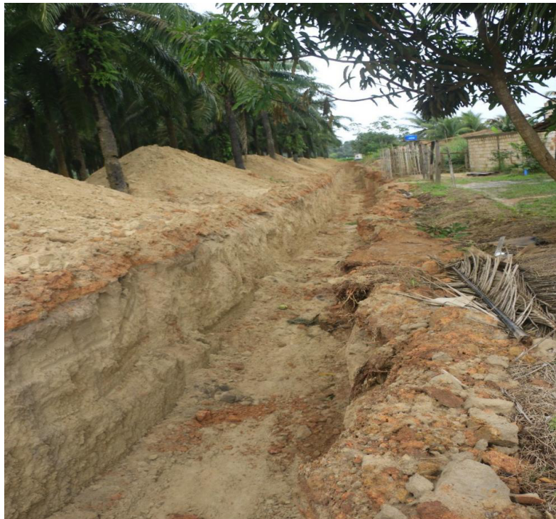
Figura 20 - Vala escavada na vila Palmares
