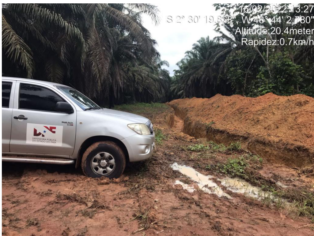
Figura 12 - Trincheira usada para interditar o acesso ao rio Acará
