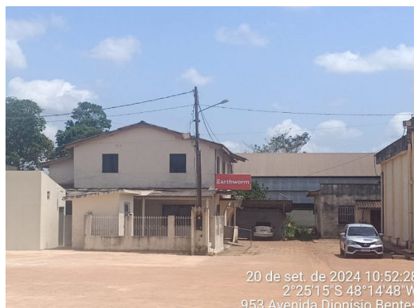
Figura 25 - Sede da Foundation Earthworm na cidade de Quatro Bocas, Tomé-Açu
