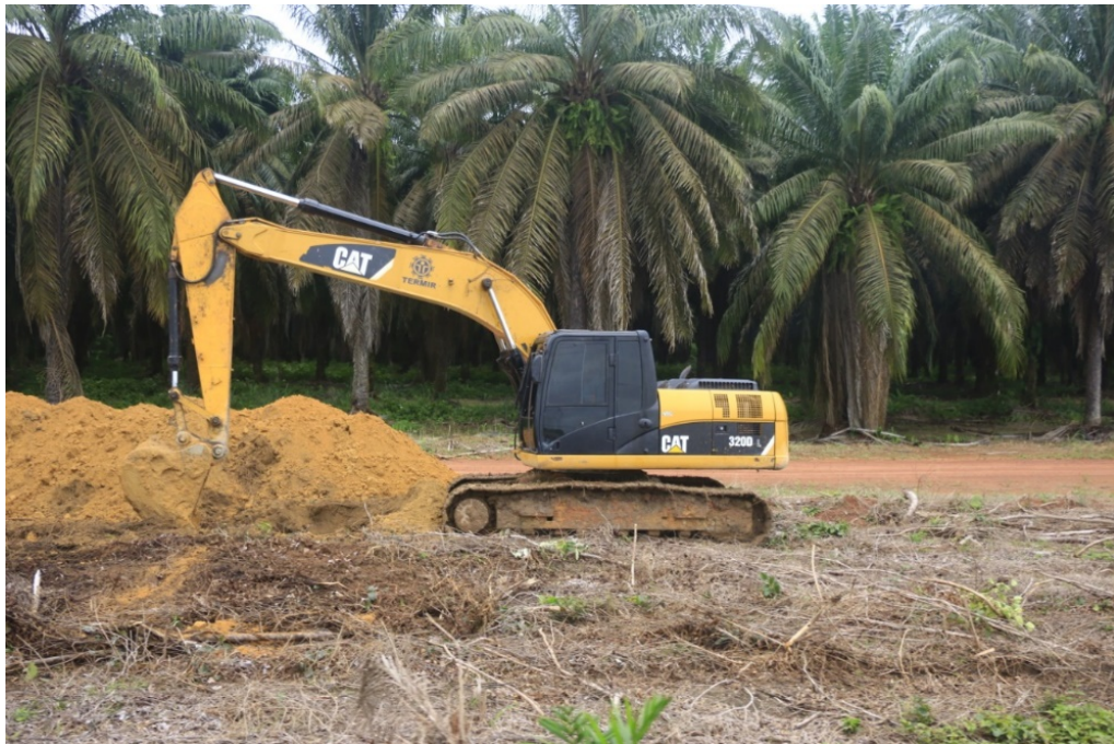
Figura 18 - Retroscavadeira utilizada na abertura de trincheiras (valas), às proximidades da Vila Palmares
