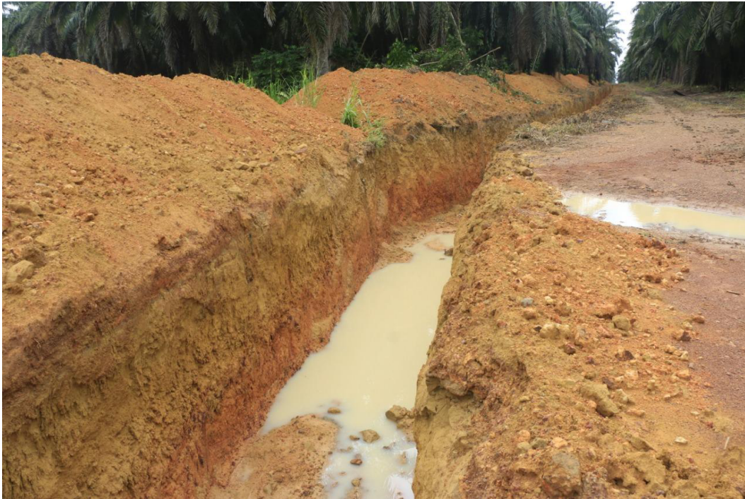
Figura 15 - Vista da profundidade da vala construída
